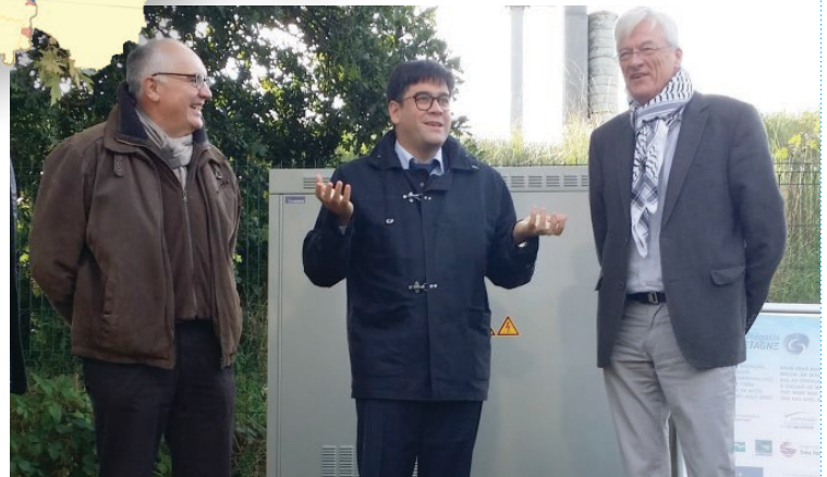
Inauguration d'une armoire Fibre Optique à Lamballe. E. Caro, G. Bui, L. Cauret
