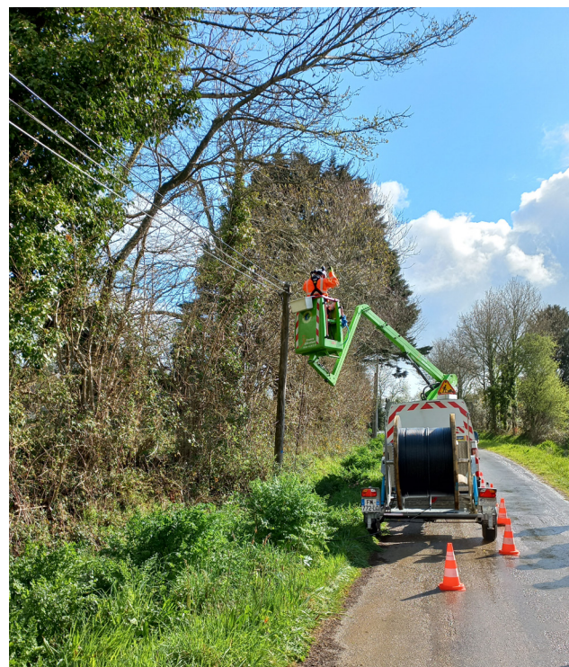
Travaux de tirage optique
