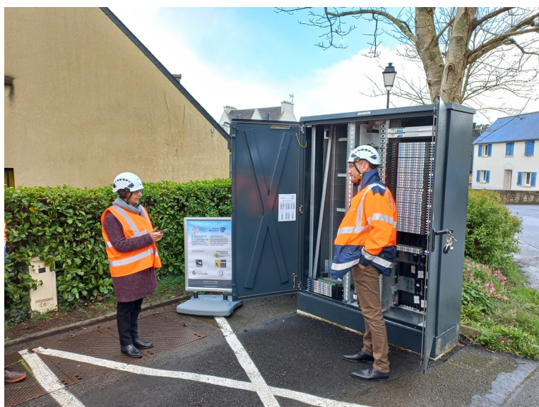
Laurence Fortin en visite sur un chantier à Loperhet (29)
